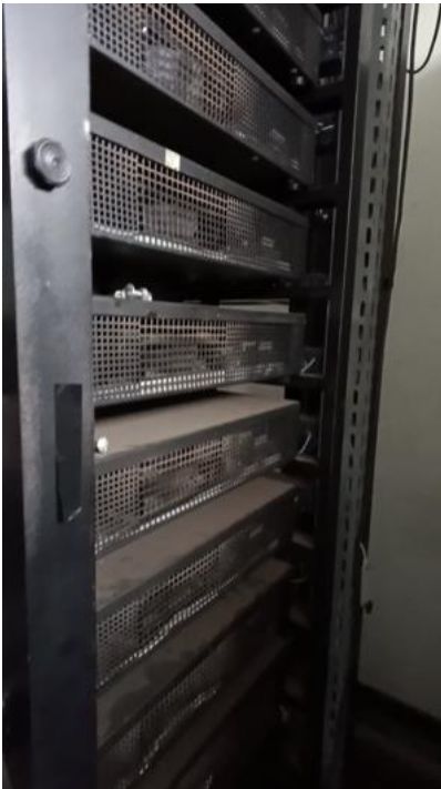
Equipamento empoeirado demonstrando falta de limpeza e manutenção
