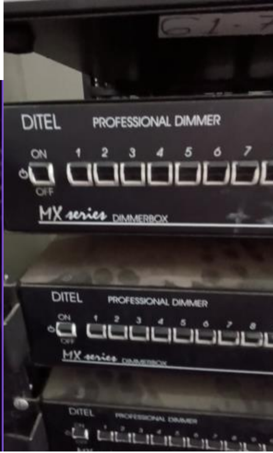
Equipamento empoeirado demonstrando falta de limpeza e manutenção
