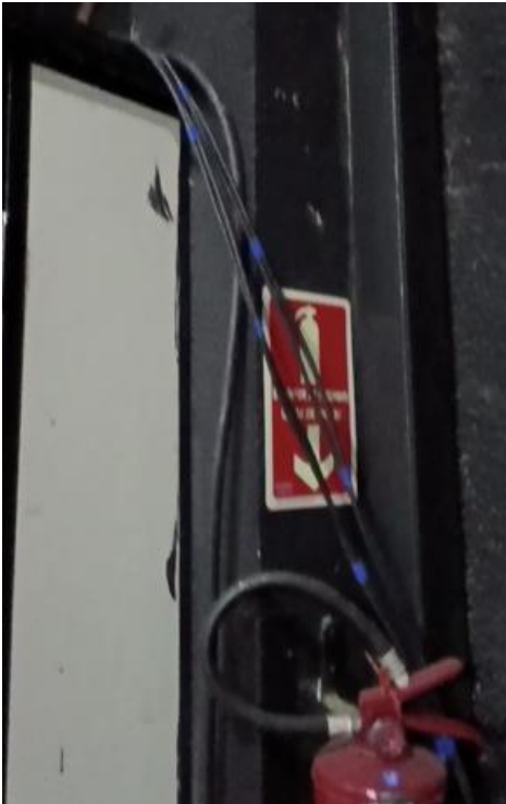
Fiação elétrica emaranhada no extintor de incêndio – varanda sem guarda corpo seguro, sem linha de vida e demais proteções para segurança para trabalho em altura
