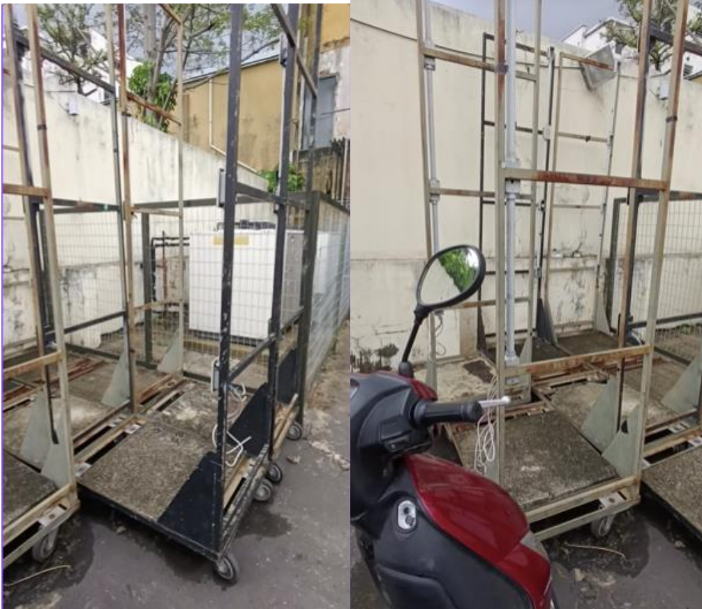
Equipamentos na chuva , enferrujados e na área de saída de emergência, junto com veículos obstruindo a saída
