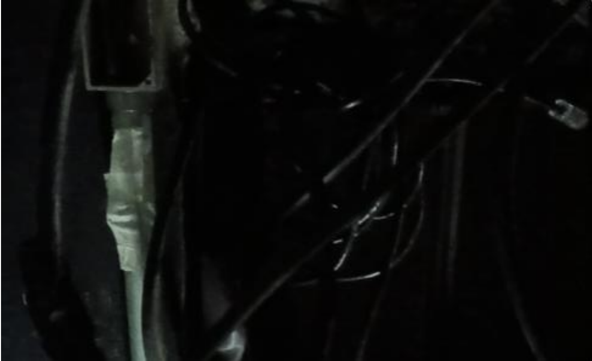
Elétrica emendada com fita crepe
